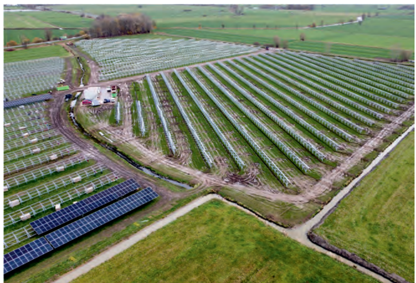
Luftbildaufnahme des im Bau befindlichen Agri-PV-Parks auf einer Fläche von 18 ha im Ortsteil Butzhausen vom Energiewirt Henning Kruse (Bericht siehe auf Seite 5).
